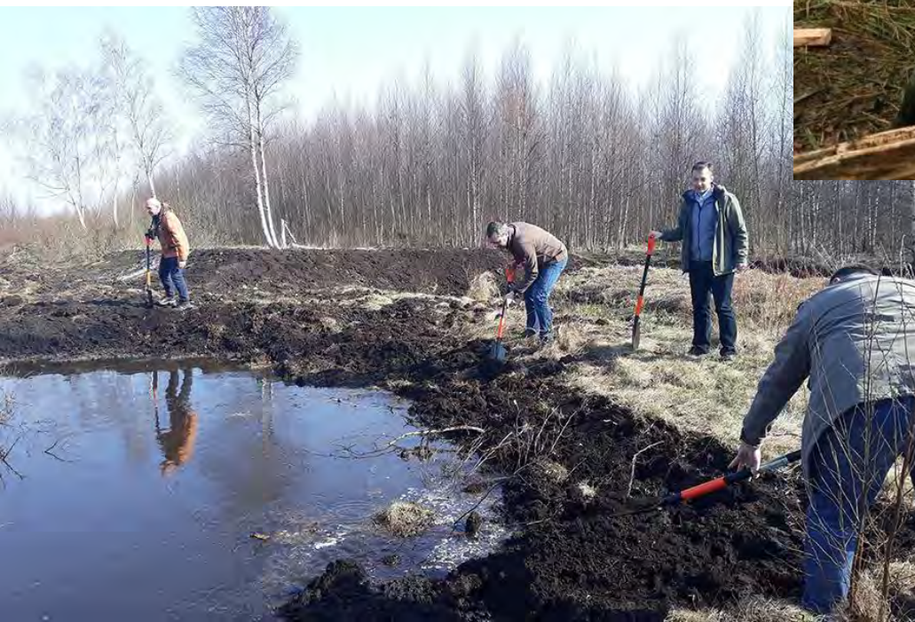
Строительство мини-плотины на реке Наревка в болоте «Дикий Никор»
