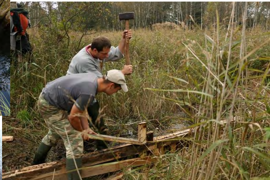
Строительство мини-плотины на мелоративном канале в «Беловежской Пуще»
