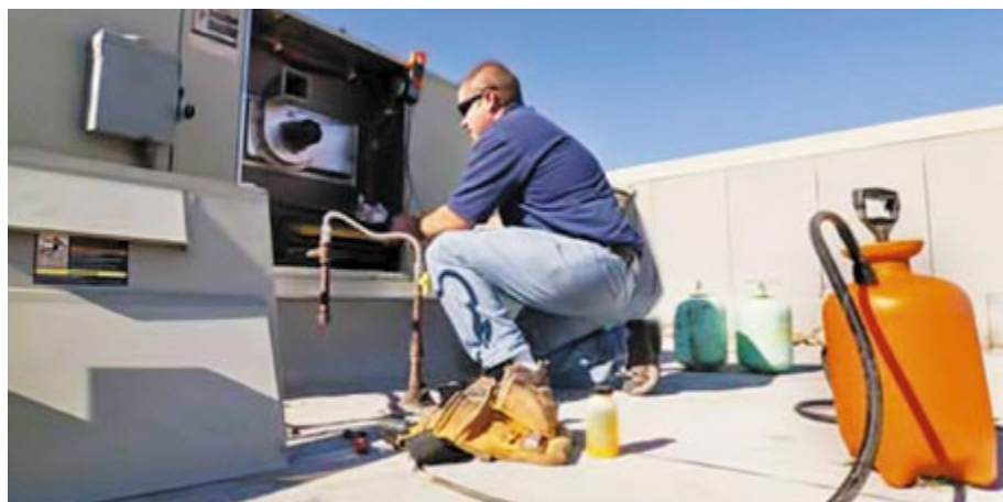
Рисунок 7: Обслуживание крышной системы
