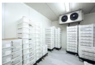
Промышленная система малой производительности - испаритель в холодильной камере
