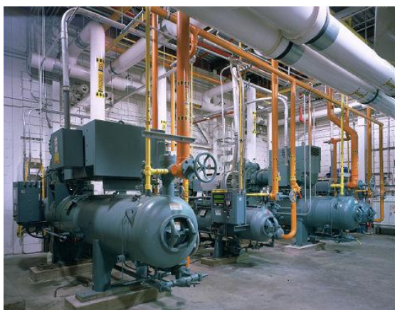
Компрессоры системы централизованного холодоснабжения большой производительности
