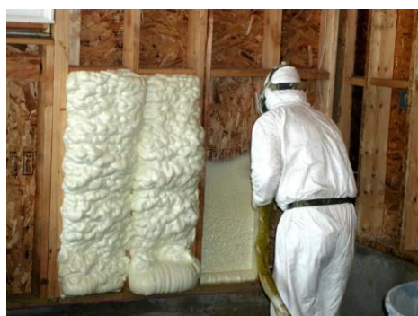
Использование монтажной пены
